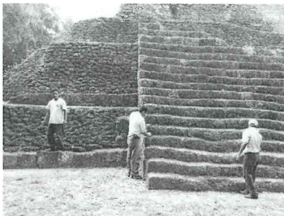
Foto 8. Edificio 152, Plaza C
